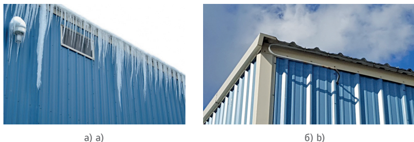
Рис. 1. Наросты льда на кромках крыш зданий ГПА (а) и защита от них (б) Fig. 1. Ice buildup on the roof edges of the gas pumping units buildings (a) and protection from that (b)
