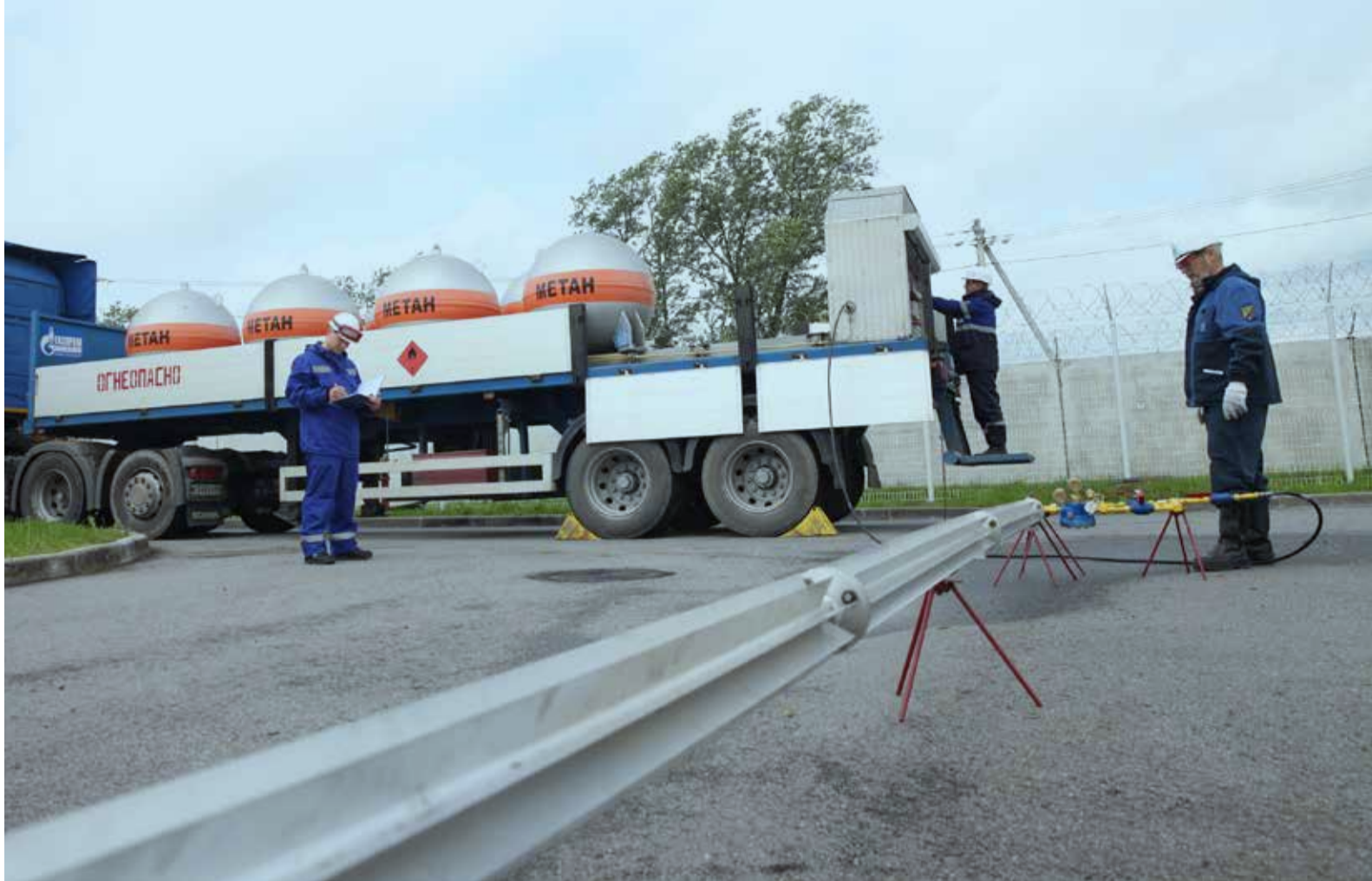
Подключение ПАГЗ к местным сетям газопотребления
