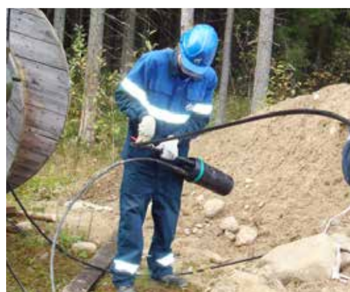
Монтаж волоконно-оптической муфты в полевых условиях
