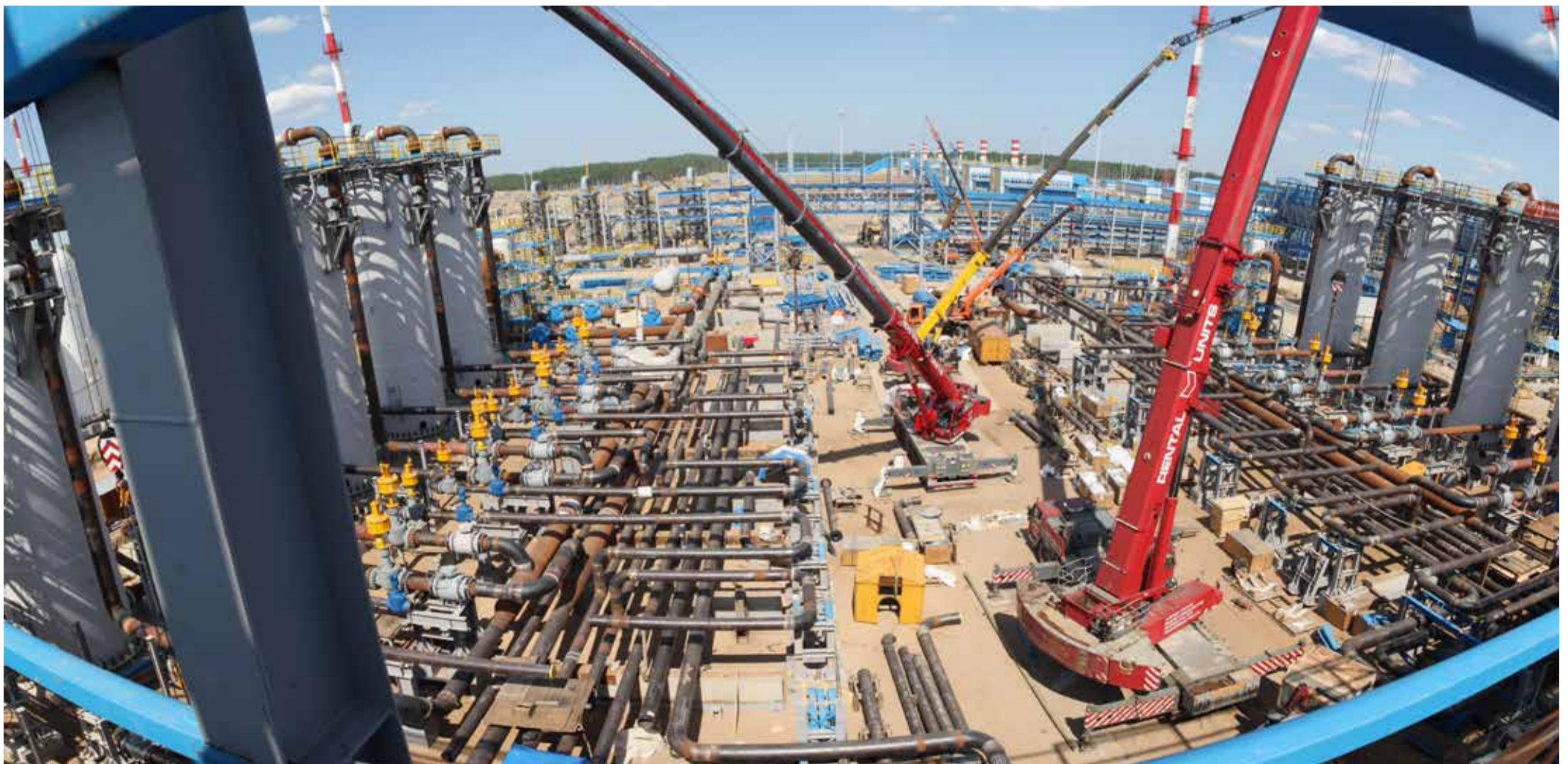
Продолжается строительство КС «Славянская»
