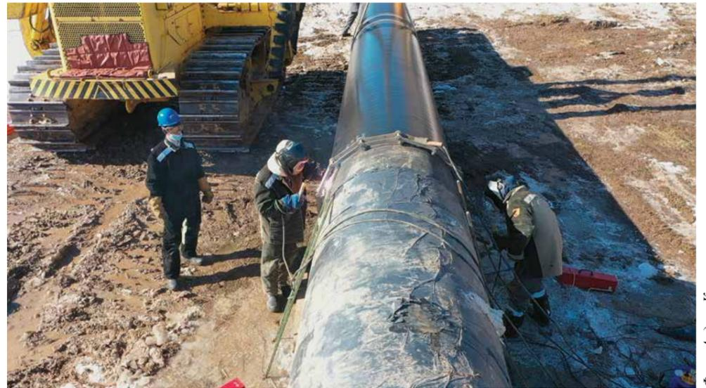
Сварка кольцевого стыка при проведении противоаварийной тренировки в Смоленском ЛПУМГ
