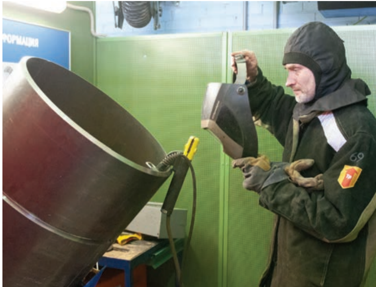
Сергей Журавлев, электрогазосварщик 6-го разряда Торжокского ЛПУМГ
