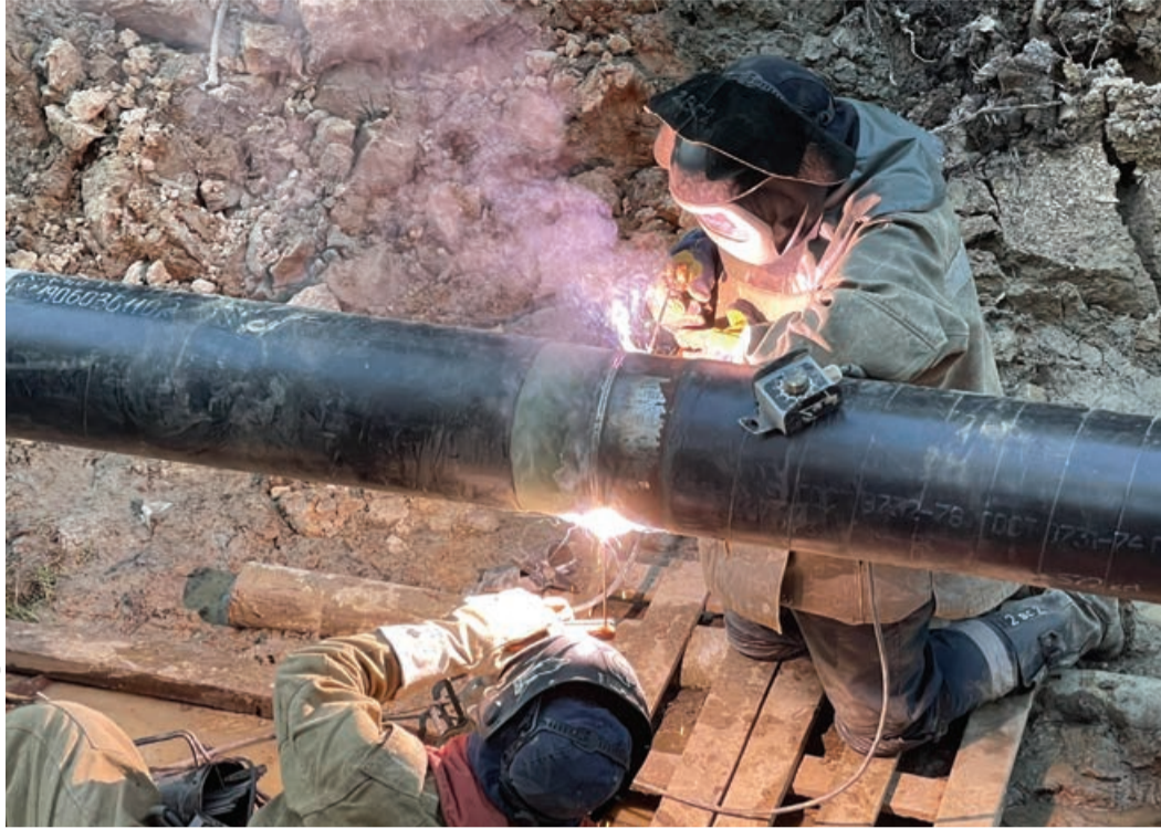
Проведение капитального ремонта на газопроводе-отводе к ГРС «Ударник». Работы выполняет сварочная бригада Управления аварийно-восстановительных работ, июнь 2022 года
