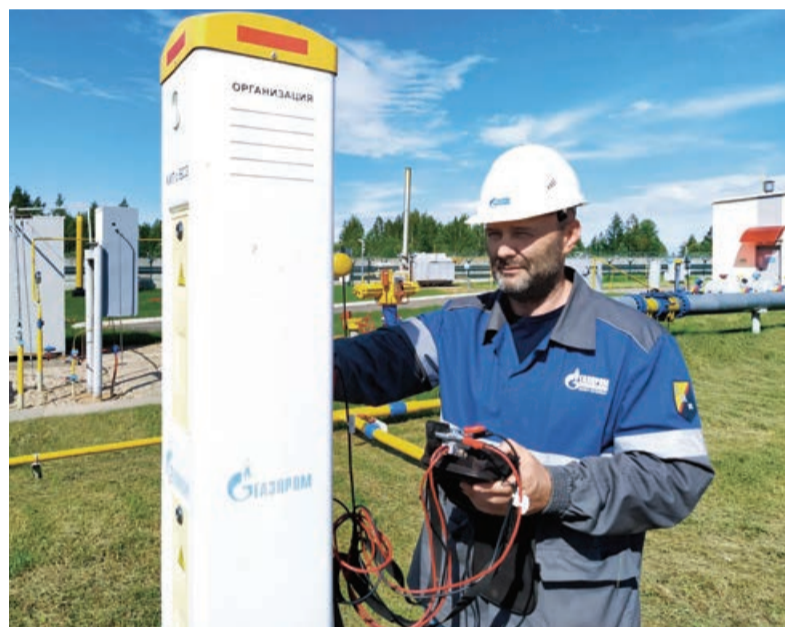
Дмитрий Каравашкин, ведущий инженер Службы защиты от коррозии Торжокского ЛПУМГ
