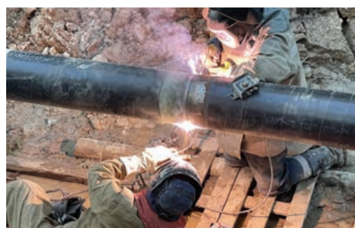
СВАРОЧНО-МОНТАЖНЫЕ РАБОТЫ стр. 2
