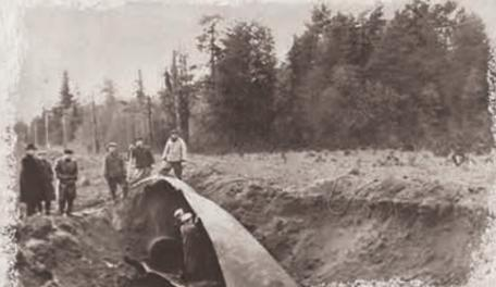
*Разрыв трубы газопровода во время испытания на валадейском участке, 1959 год*
