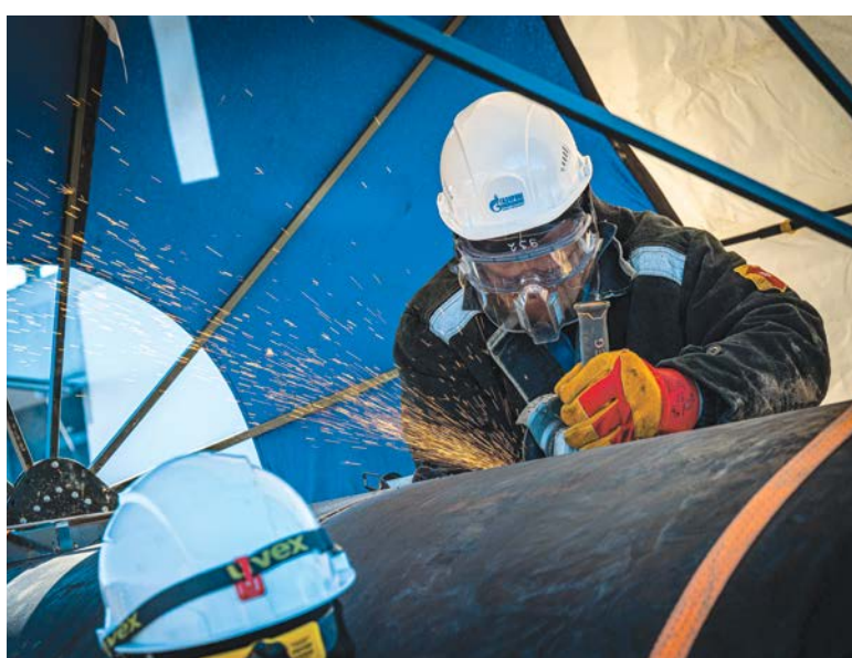
Подготовка кромок трубы
