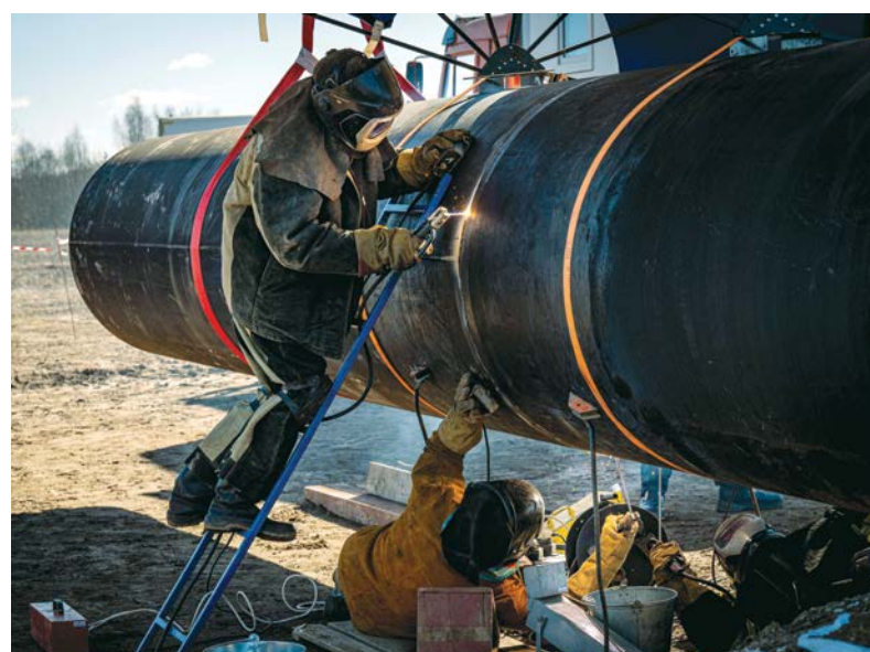
Выполнение сварочно-монтажных работ
